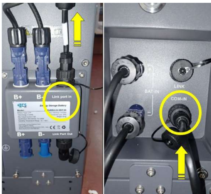
Rysunek 132 - Podłączenia komunikacyjne: BDU i pierwszy moduł baterii
