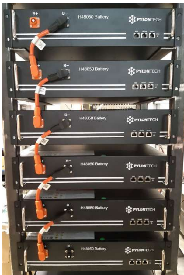
Rysunek 42 - Okablowanie zasilania pomiędzy modułami baterii
