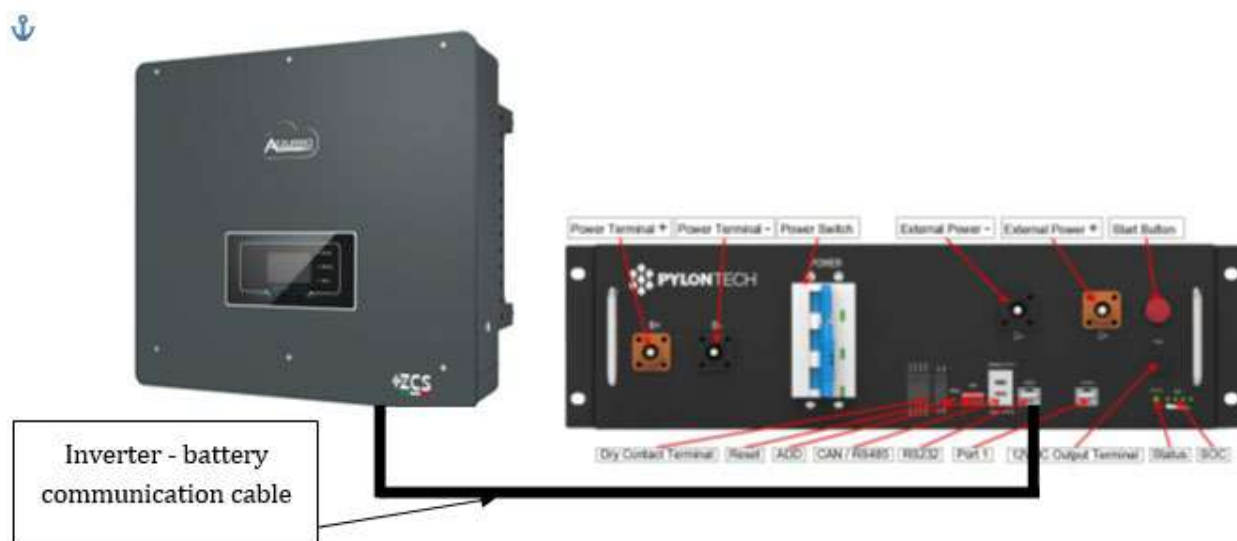
Rysunek 32 - Podłączenie komunikacyjne falownika hybrydowego i BMS
