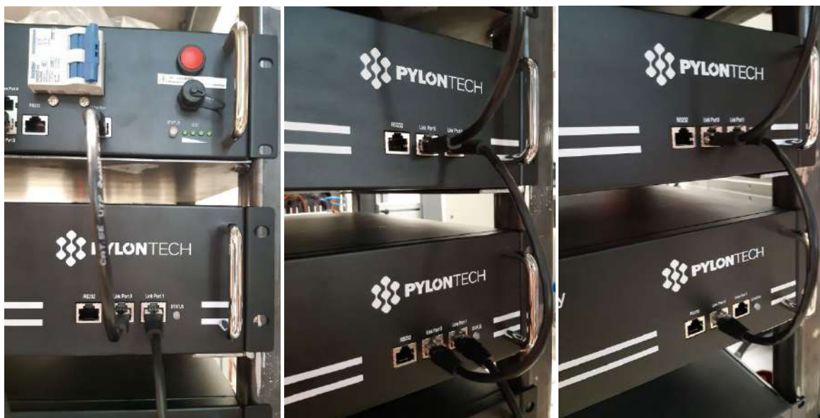
Rysunek 31 - Podłączenia komunikacyjne: BMS i pierwszy moduł baterii (po lewej), podłączenie między modułami baterii (w środku), podłączenie między przedostatnim i ostatnim modułem baterii serii (po prawej)
