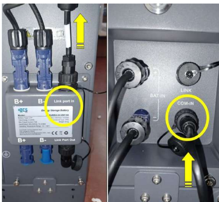
Rysunek 116 - Podłączenia komunikacyjne: BDU i pierwszy moduł baterii
